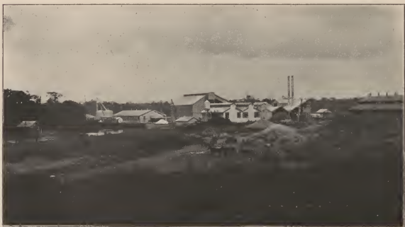
93. FABRIEKSGEBOUWEN TE MOENGO
